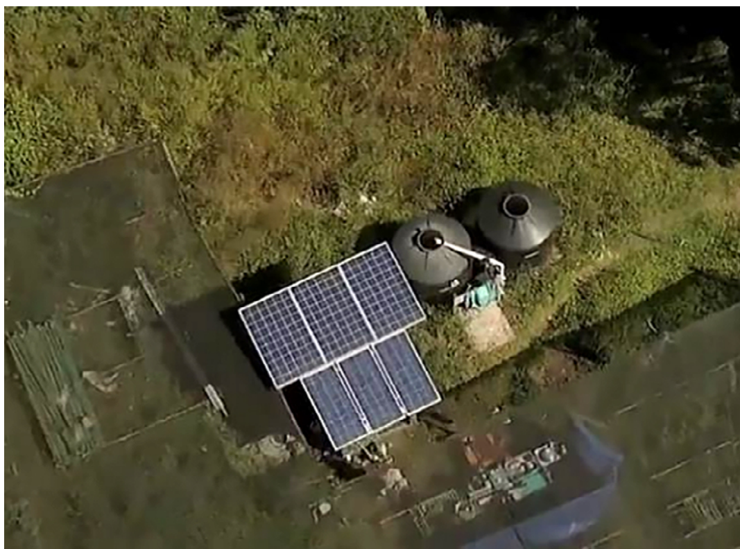
Sistema de bombeo de electrificación para procesos productivos en comunidades aisladas y zonas rurales de San Felipe Usila, Oaxaca, implementado en junio de 2018. (FOTEASE, 2022)
